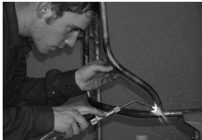
La maîtrise parfaite de la soudure un atout pour la bonne réalisation des travaux
