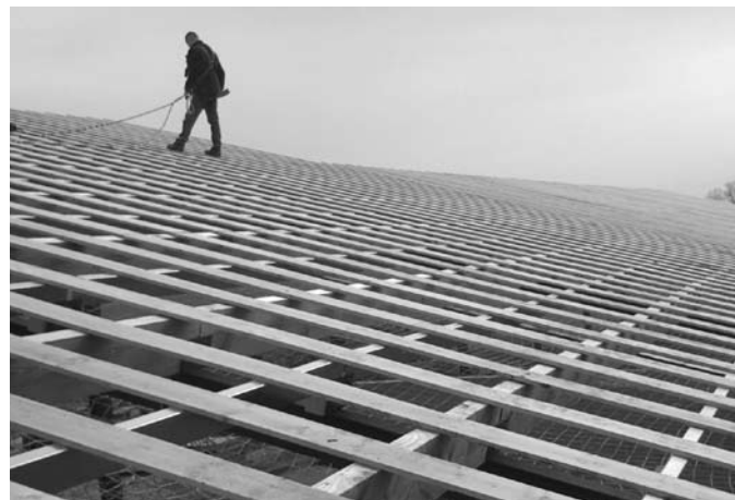
La pose d'une centrale solaire par l'entreprise SEBDO : la charpente est prête à recevoir les panneaux solaires !
